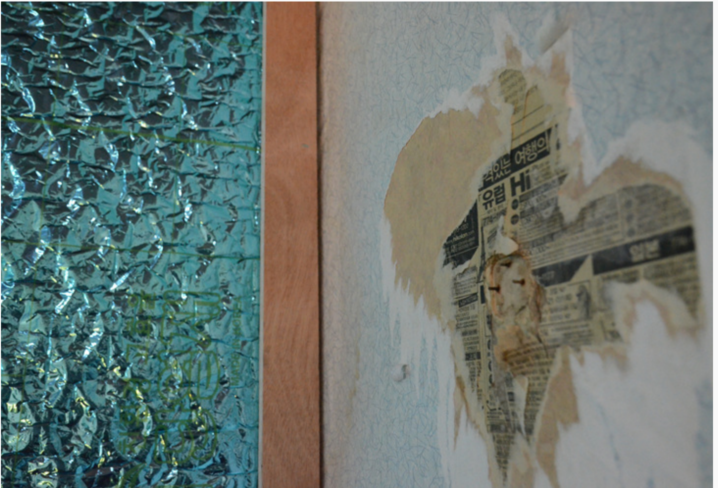
▲시공 중인 단열재(왼쪽)와 신문지로 덧댄 기존 벽
